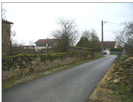
Petits muret dégradé situé dans une ruelle.
