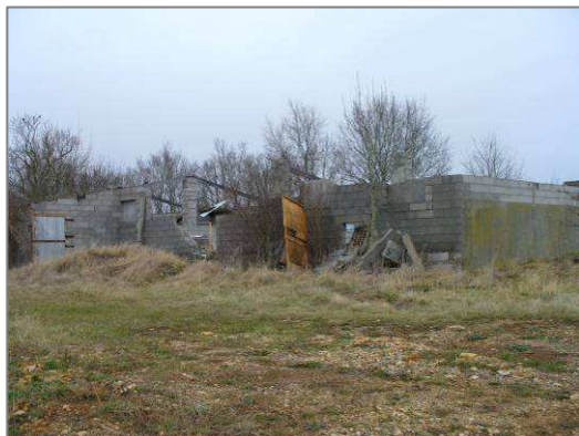
Hangar à l'abandon à l'entrée du village.
